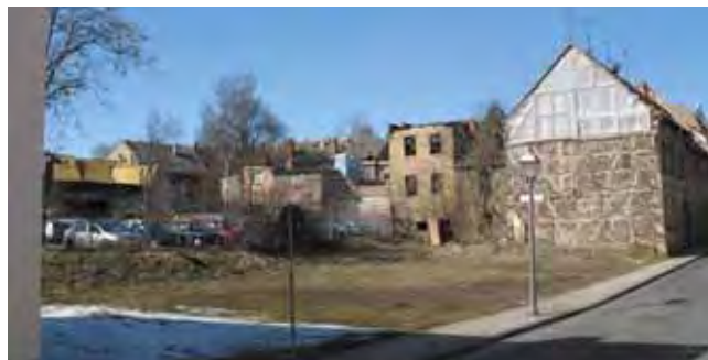
Abbruchfläche in der Zeißingstraße 48,49
