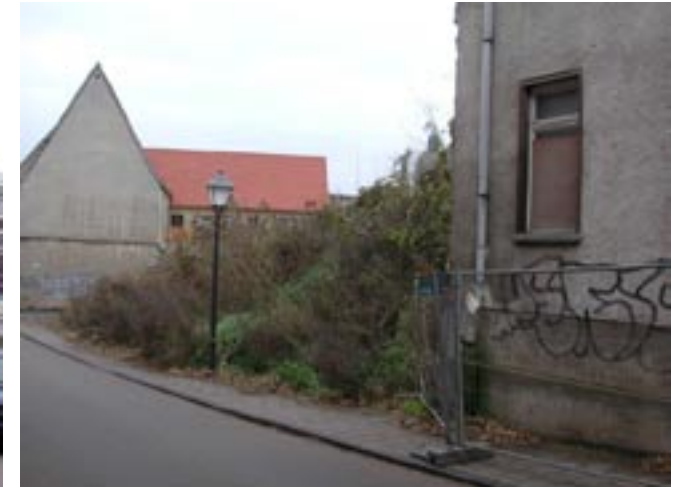
Baulücke Rammtorstraße 11-15 mit Blick auf den Giebel des Ackerbürgerhauses
